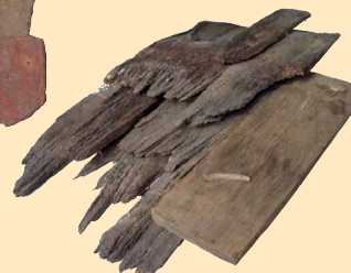
▲ Essentes : essai de restitution d'une toiture en tuiles d'essentes avec des éléments retrouvés sur les voûtes de l'église de Montreuil-le-Henri et un autre, avec sa cheville, provenant du château de Bouloire
