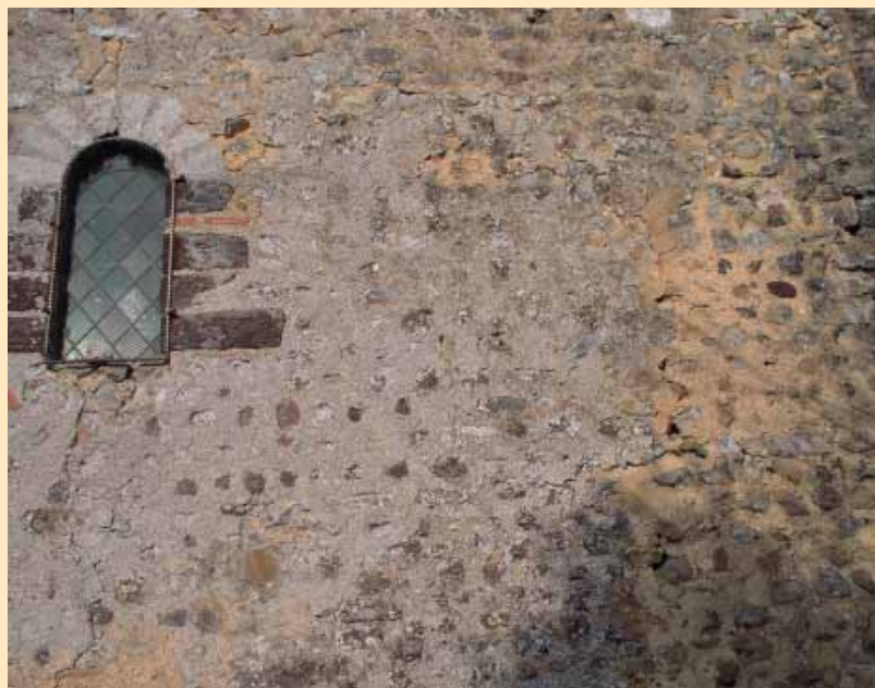
▲ Mur en petit appareil et fenêtre meurtrière avec linteau clavé de la chapelle de Montreuil
