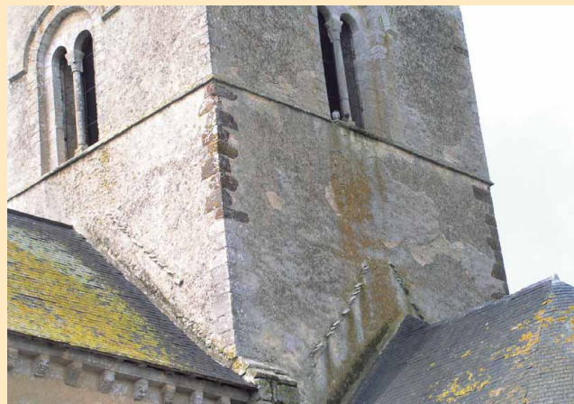
▲ Tennie : bandeau saillant en moellons, destiné à l'étanchéité entre le mur et la toiture
